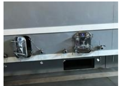
コンクリート製のタンク
