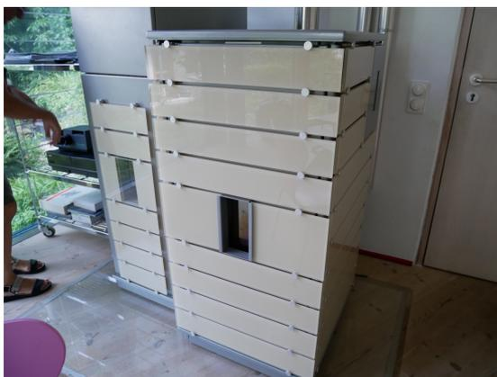
木質ペレットを用いた熱供給機
